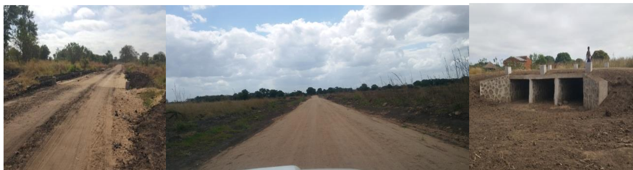
Ensaibramento da plataforma para melhoria da drenagem ao longo da via
