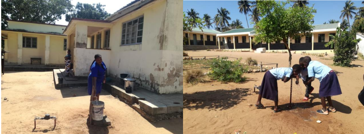
Torneiras instaladas nas instituições públicas de Mangonha: Centro de Saúde e EPI
