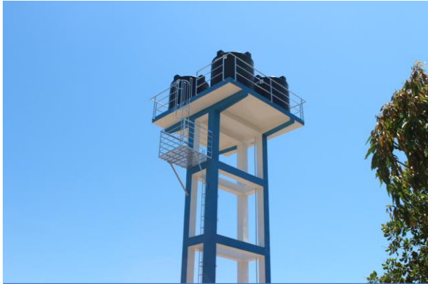
Centro distribuidor com 12 m de altura e 4 depósitos plásticos de 5 m 3 cada. À direita, um dos fontanários instalados num dos bairros de Mepapata
