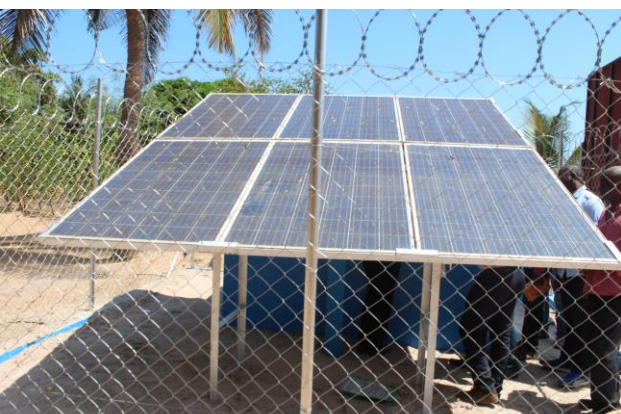
À esquerda e à direita, pode ver-se a fonte de captação com os respectivos painéis solares, que alimentam a corrente para enchimento dos depósitos elevados na torre
