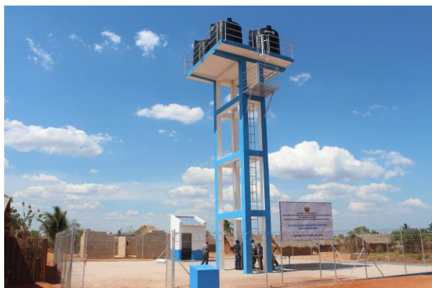
Centro distribuidor com quatro tanques plásticos com capacidade de 5 m 3 cada. À esquerda, uma fila enorme no fontanário em funcionamento
