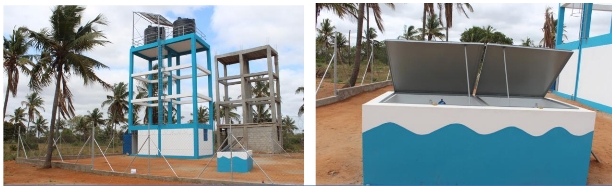
Centro distribuidor com dois depósitos com capacidade de 10 m 3 cada. À direita, caixa na fonte de captação
