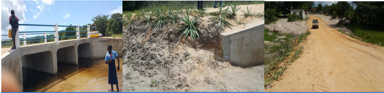
As imagens ilustram obras de arte, protecção dos encontros da ponte e revestimento de taludes
