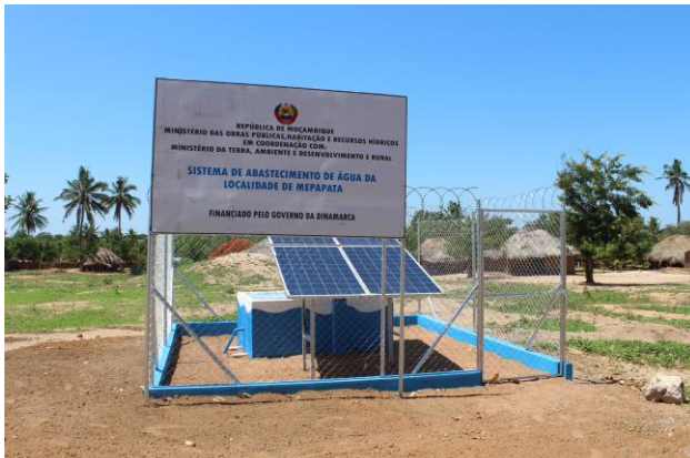
Fonte de captação com recurso a painéis solares e torneira montada na EPI de Mepapata
