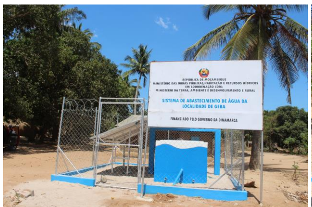
À esquerda e à direita, pode ver-se a fonte de captação com os respectivos painéis solares, que alimentam a corrente para enchimento dos depósitos elevados na torre
