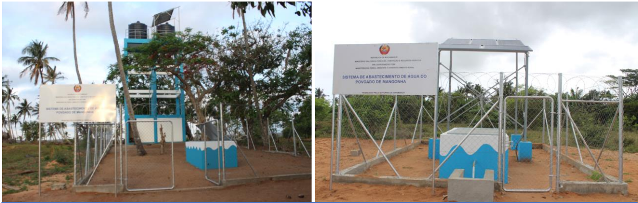
Centro distribuidor com dois depósitos plásticos com capacidade de 10 m 3 cada. À direita, o segundo furo de reforço da captação com recurso ao uso de painéis solares
