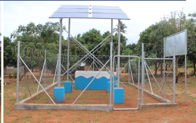
Centro distribuidor com dois depósitos plástico com capacidade de 10 m 3 cada. À direita, furo de captação com recurso ao uso de painéis solares
