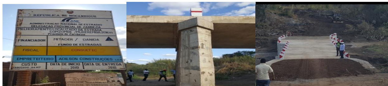
Placa de identificação da obra, estrutura da ponte e trabalho da sua reposição, depois dos danos causados pelo ciclone Idai
