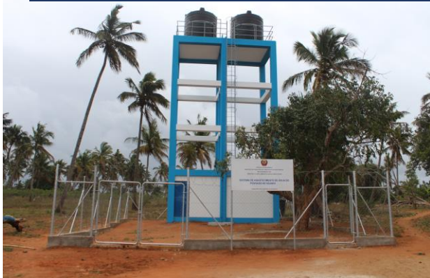
Centro distribuidor com dois depósitos plástico com capacidade de 10 m 3 cada. À direita, furo de captação com recurso ao uso de painéis solares
